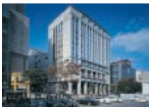
空調・給排水衛生設備工事
