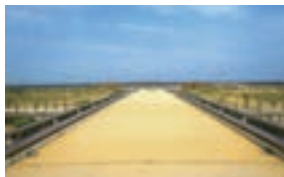
海の中道海浜公園プロムナードデッキ橋
